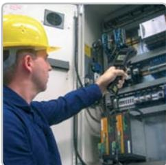
Nahezu jedes Betriebsmittel, welches Strom verbraucht, wird vor Auftreten einer Störung heiß. Die Temperaturüberwachung mit einem optris LS LT ist hier ein wichtiges Instrument bei der vorbeugenden Instandhaltung.
