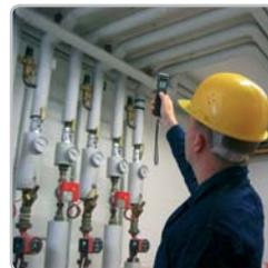
Das optris MS Pro LT spart Zeit und Geld bei der Wartung von Heizungs-, Lüftungs- und Klimaanlage. Fehlerquellen wie Lecks oder verstopfte Filter können in kürzester Zeit lokalisiert und außerplanmäßige Abschaltungen vermieden werden.
